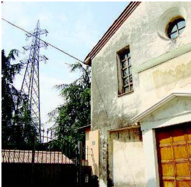
I tralicci nel parco di Lovernato, vicino alle abitazioni
